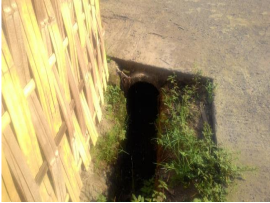
Gambar 9 Kondisi saluran setelah dilakukan normalisasi
