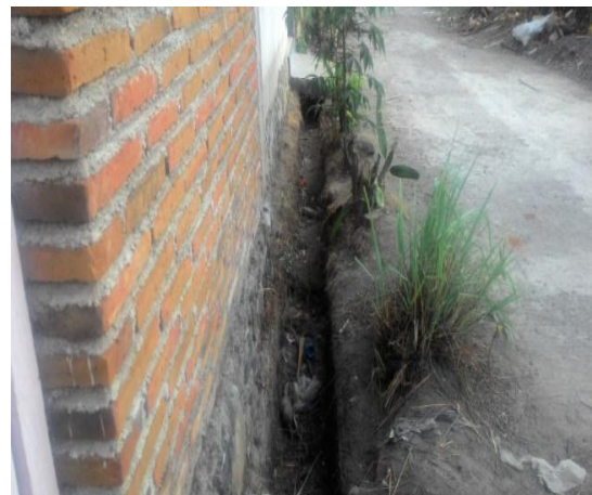
Gambar 7 Kondisi saluran setelah dilakukan normalisasi
