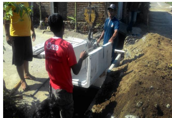
Gambar 14 Proses erection U-ditch pada saluran
