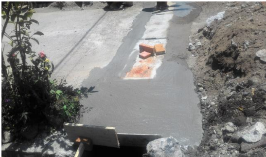
Gambar 16 Finalisasi pemasangan U-ditch
