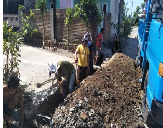
Gambar 12 Finalisasi galian tanah dibawah lapisan beton
