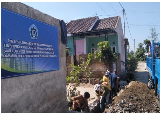
Gambar 11 Galian jalan beton untuk membuat saluran melintang jalan
