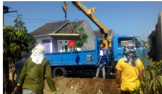
Gambar 13 Proses penurunan U-ditch dari truk menggunakan crane
