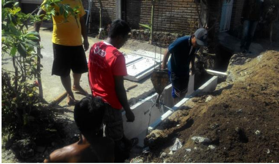
Gambar 15 Pengecekan elevasi saluran setelah U-ditch dipasang
