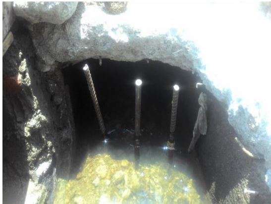
Gambar 17 Pemasangan penyaring sampah pada mulut gorong-gorong eksisting
