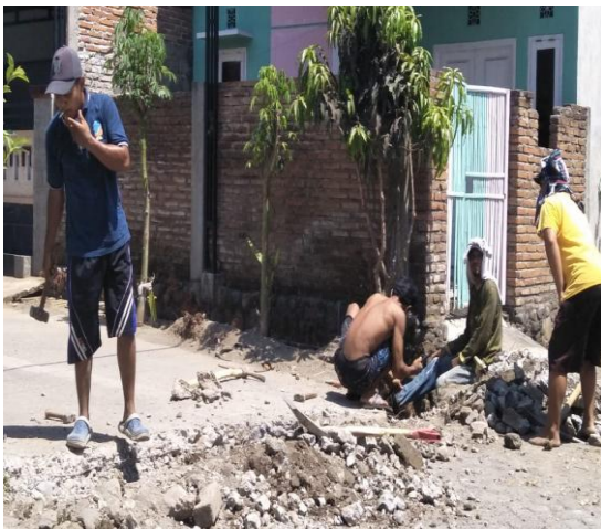
Gambar 10 Pengupasan jalan beton untuk persiapan saluran melintang jalan
