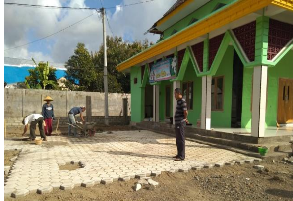
Gambar 11 Proses pemeriksaan dan pengawasan pemasangan paving
