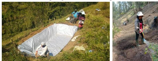
Gambar 6. Perbaikan instalansi air
