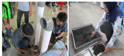
**Gambar VII.** (a) Pembuatan Trial Instalasi Pipa Filter; (b) Proses Pembuatan Filter Beton Pasir (Dok, 2016)
