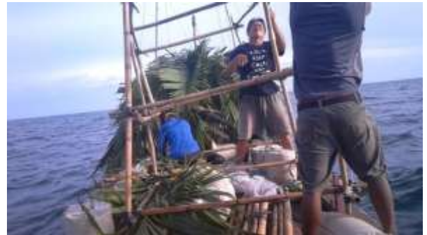
Gambar 10. Proses Pemasangan Rangka Rumpon
