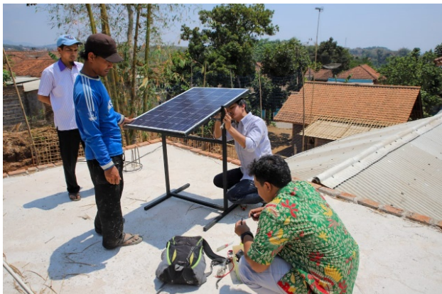
Gambar 2. Pemasangan panel surya
