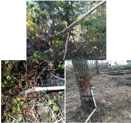
Fig. 22-24. Pemasangan pipa irigasi 3 tahap hingga air dapat mencapai lokasi PKM (350m dari sumber air)
