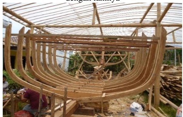
Gambar 8. Proses pemasangan frame lambung
