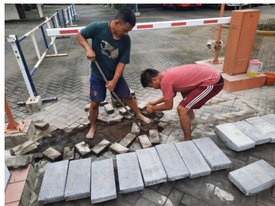
Gambar 7: Proses pembongkaran paving lama
