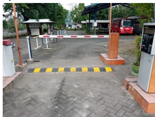
Gambar 8: Hasil akhir pemasangan paving block polisi tidur ( speed bump )
