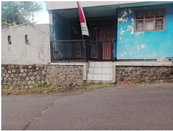
Gambar 6. Hasil Akhir Pemasangan Pagar
