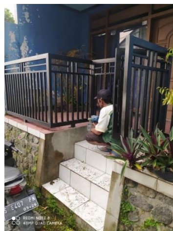
Gambar 5. Proses Pemasangan Pagar
