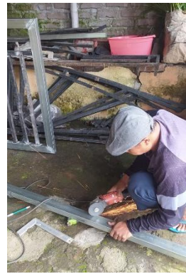
Gambar 3. Proses Pengukuran dan Pemotongan
