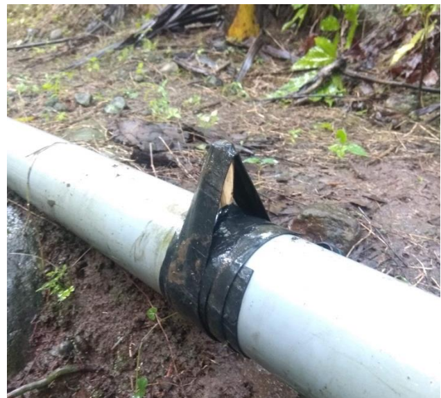
Gambar 2. Penambalan sederhana pada kebocoran pipa
