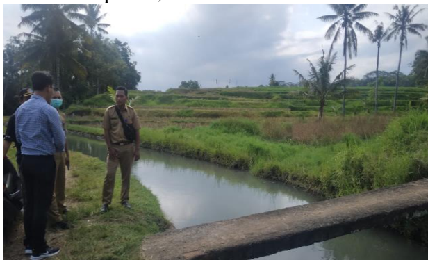
Gambar 1 Kondisi Eksisting Jembatan
