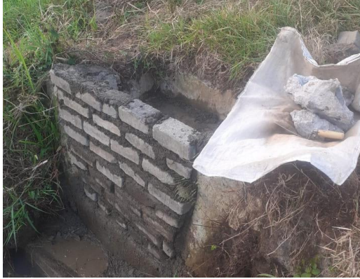
Gambar 6. Pembuatan Abutment Jembatan
