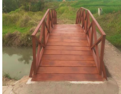
Gambar 8. Hasil Finishing Jembatan
