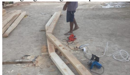
Gambar 5. Pembuatan Gelagar Jembatan
