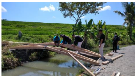
Gambar 7. Pemasangan Jembatan
