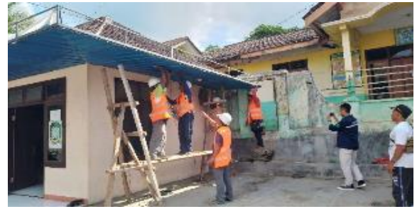
Gambar 8. Pembongkaran Kanopi Lama
