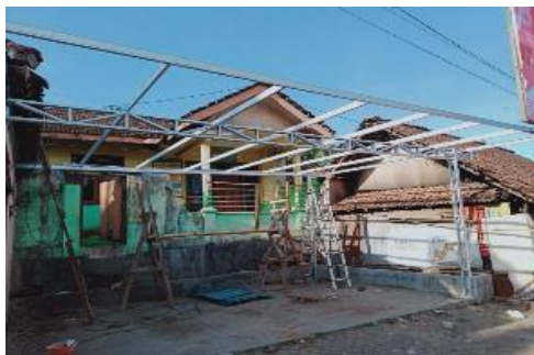
Gambar 9. Rangka Kanopi
