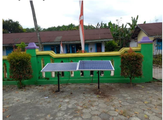
Gambar 7. Pemasangan Panel Surya di Halaman Masjid Al Amien
