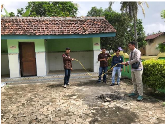
Gambar 5. Pengukuran Tempat Peletakan Panel Surya
