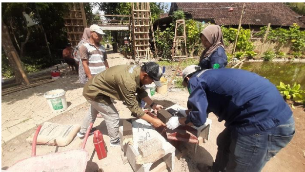
Gambar 4. Demo Pembuatan Eco Paving Block
