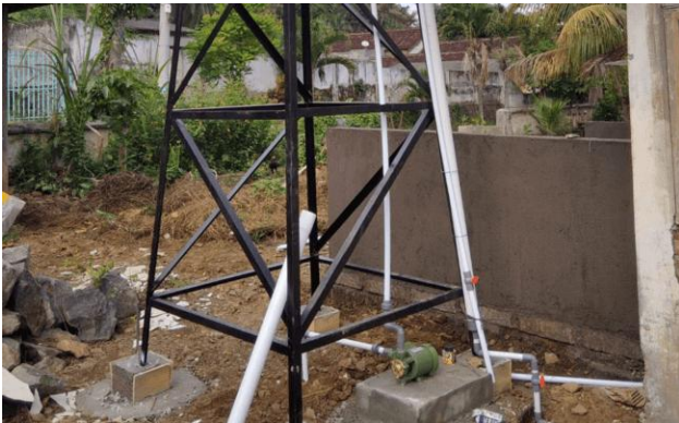
Gambar 5. Pemasangan Menara dan Jaringan Pipa
