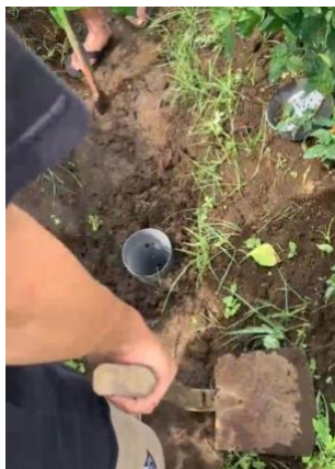
Gambar 5. Pemasukan pipa kedalam lubang
