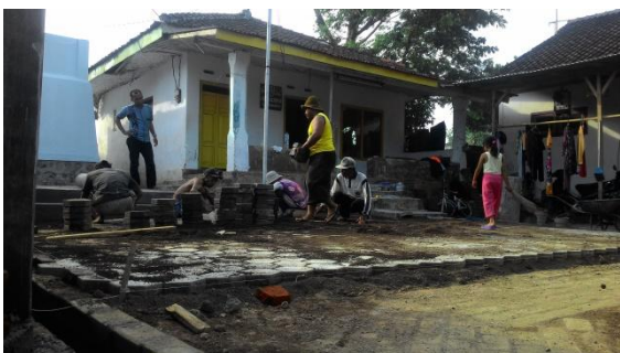
Gambar 13 Pelaksanaan pemasangan paving pada halaman mushollah Ar-Roudhoh
