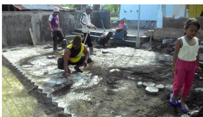
Gambar 11 Pemasangan paving dilakukan secara gotong royong bersama takmir dan warga
