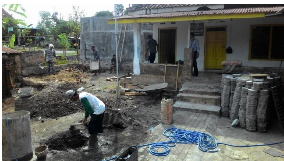
Gambar 10 Persiapan pemasangan paving di halaman Mushollah Ar-Roudhoh
