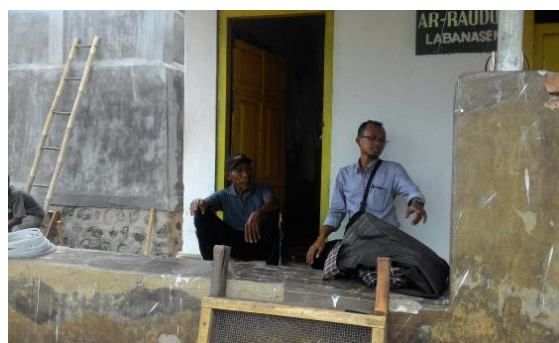
Gambar 8 Koordinasi dengan perwakilan masyarakat mengenai persiapan pemasangan paving
