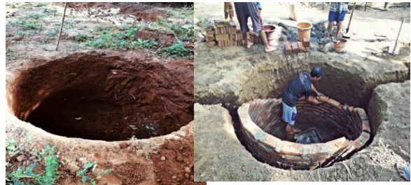
Gambar 2. Penggalian dan pengecoran dinding tanah
