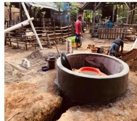
Gambar 3. Pembuatan digester dan penyambungan pipa
