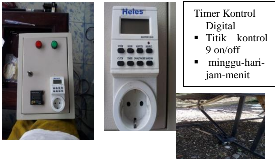
Gambar 6. Timer Digital penggerak kolektor Sistim kontrol sirkulasi air panas
