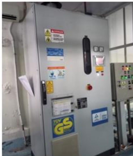
Gambar 3. Generator Ozon yang digunakan dalam Penelitian Sumber : PT. Tirta Sukses Perkasa Jember
